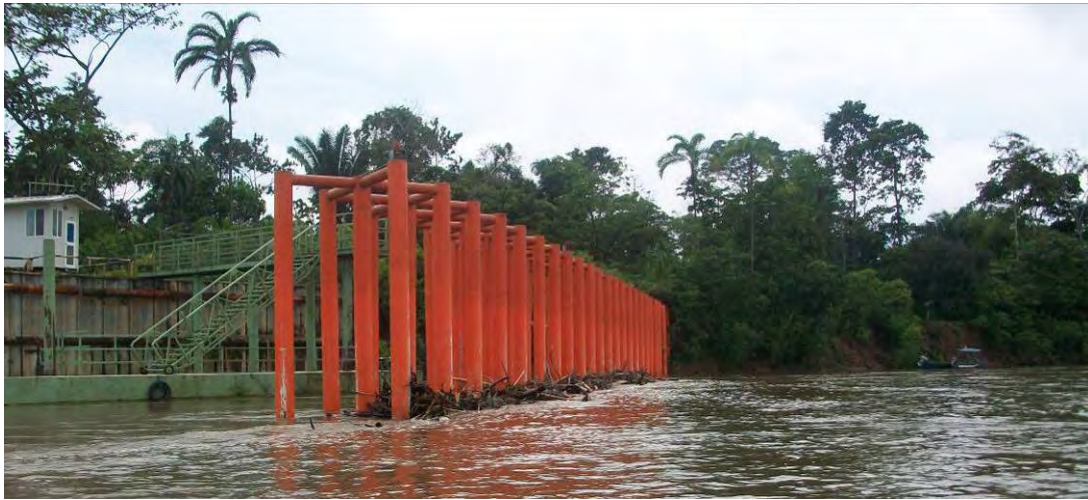
Figura 3.7–5. Defensas contra palizadas reforzadas con arriostramientos horizontales en una instalación de embarque y desembarque perteneciente a la industria petrolera (proximidades de Chiro Isla, tramo ecuatoriano del río Napo)
