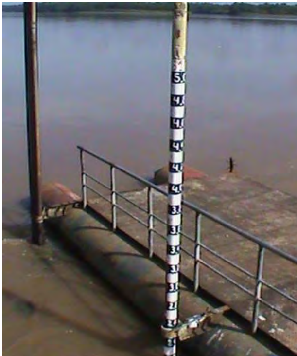
Figura 3.7–3. Embarcadero de Nuevo Rocafuerte. Pilotes Guía del Pontón flotante
