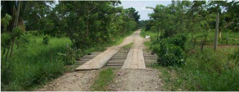
Figura 3.5–5. Tramo de camino afirmado a mejorar para el acceso a Belén / Providencia
