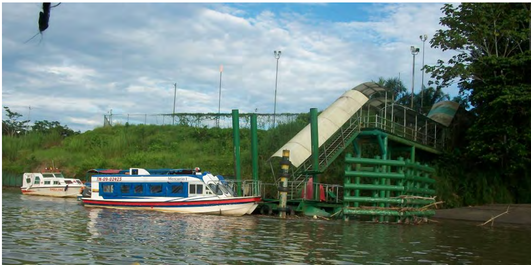
Figura 3.7–4. Típicos muelles flotantes con defensas contra palizadas reforzadas con arriostramientos horizontales (tramo ecuatoriano del río Napo)
